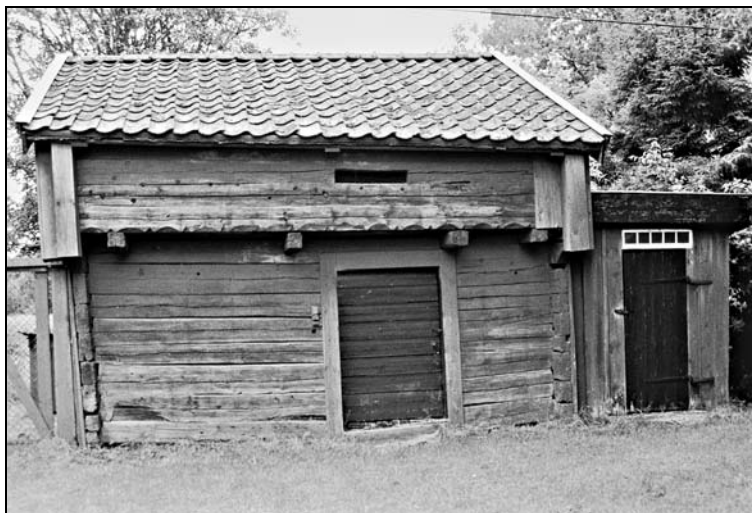
Loftbod med utkragad övervåning i Långshult, Rydaholm. I den nedre bjälken finns en utskuren dekoration
